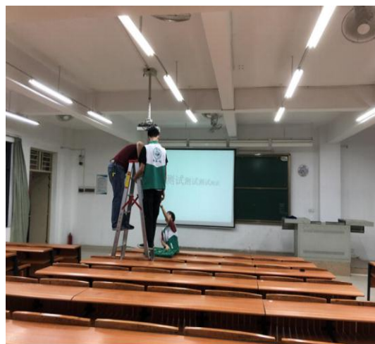
检修人员与教务处课室管理人员对投影仪进行调试
